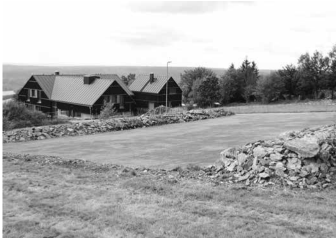
Der fertige Parkplatz oberhalb vom Aschberghaus
